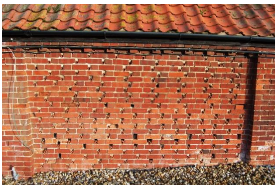
17) Brick vent detailing
