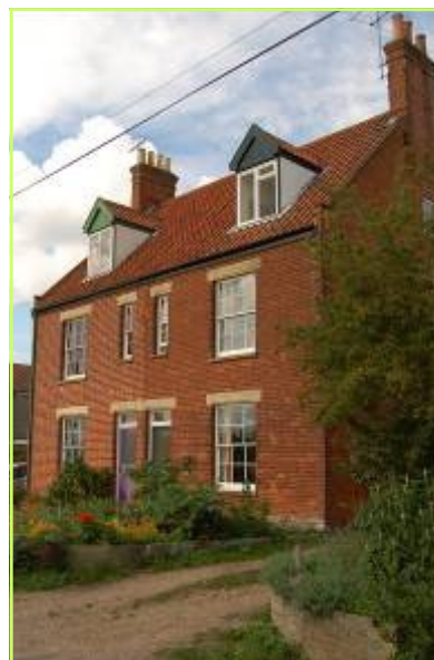
Fig 34, Nos. 21-23 , Mill Lane
